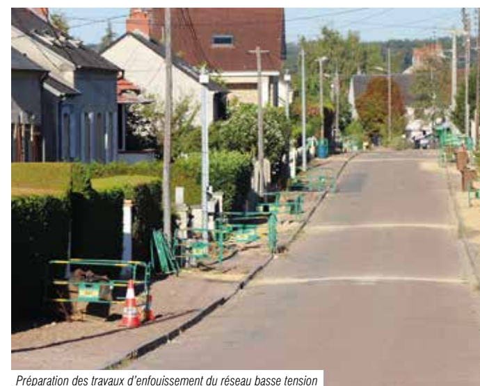
Préparation des travaux d'enfouissement du réseau basse tension
