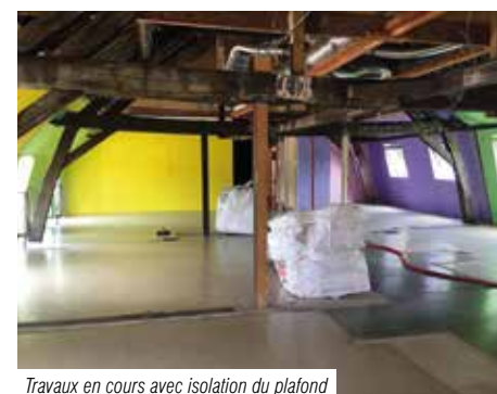
Travaux en cours avec isolation du plafond
