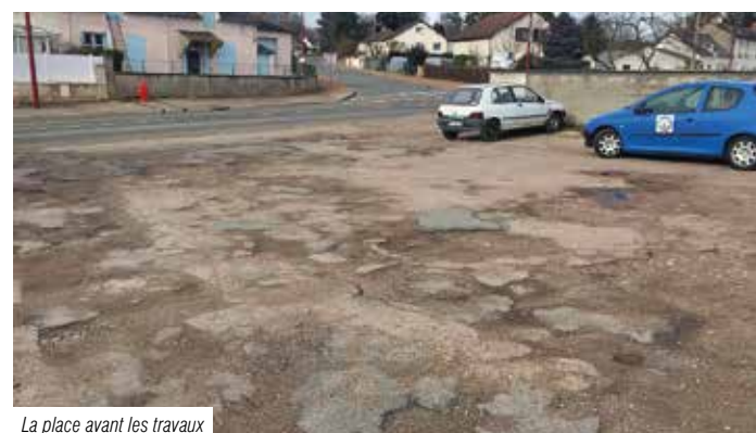
La place avant les travaux
