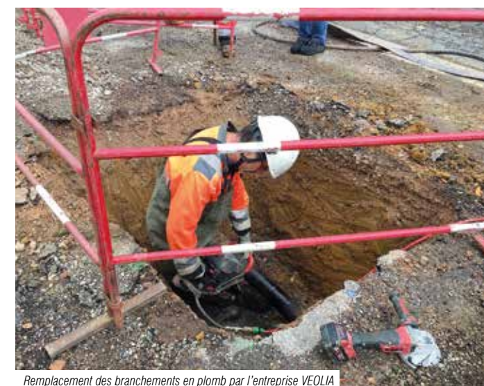
Remplacement des branchements en plomb par l'entreprise VEOLIA
