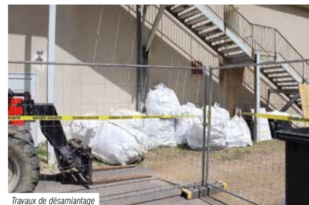
Travaux de désamiantage
