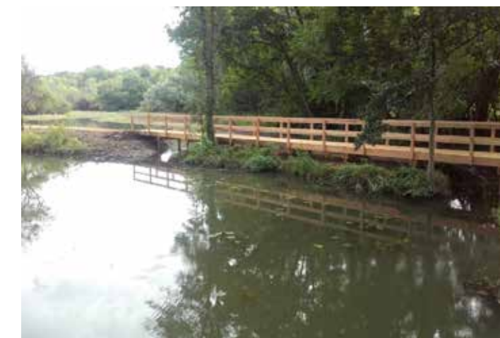
Pilotis passant par-dessus la connexion de la zone humide et le ruisseau du Lavoir.
