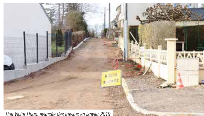
Rue Victor Hugo, avancée des travaux en janvier 2019
