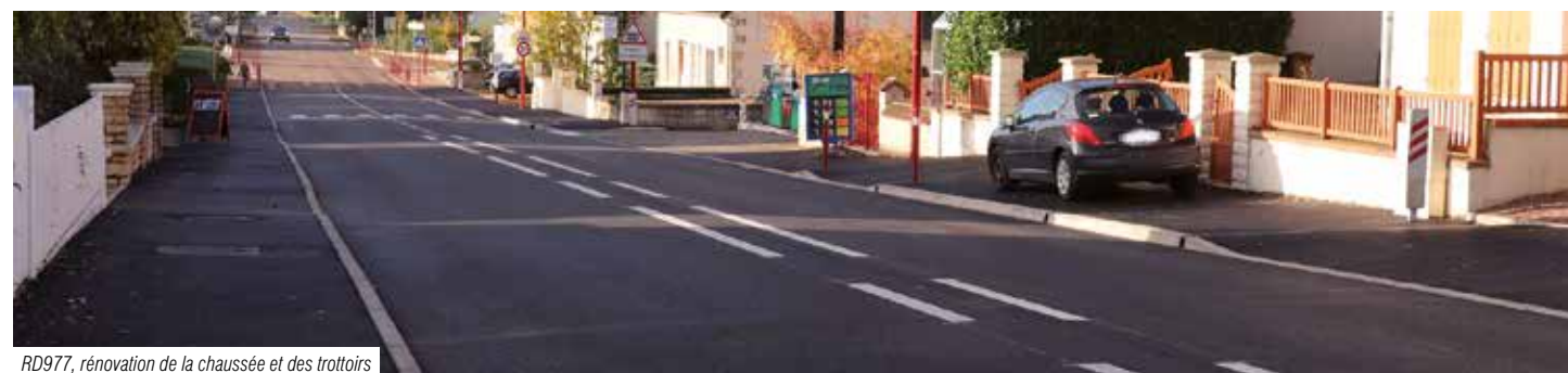
RD977, rénovation de la chaussée et des trottoirs
