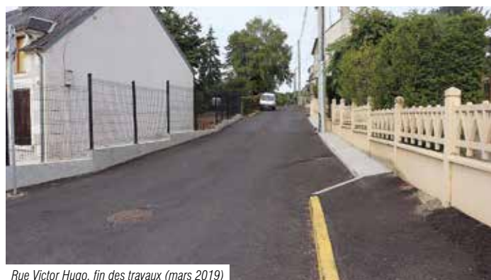
Rue Victor Hugo, fin des travaux (mars 2019)
